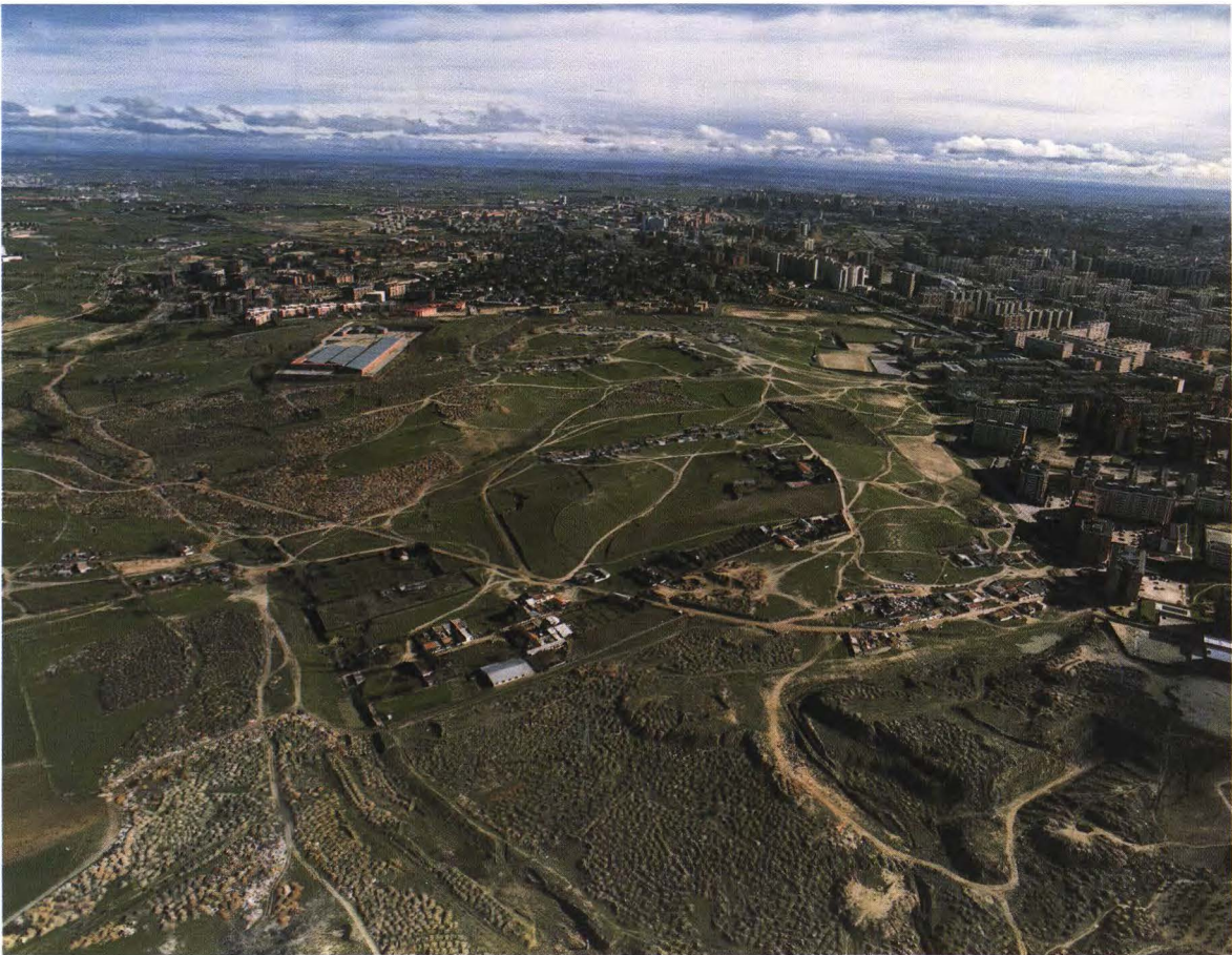
Ambito del Arroyo del Fresno (1988). Desde entonces han aumentado los asentamientos autoconstruidos.
